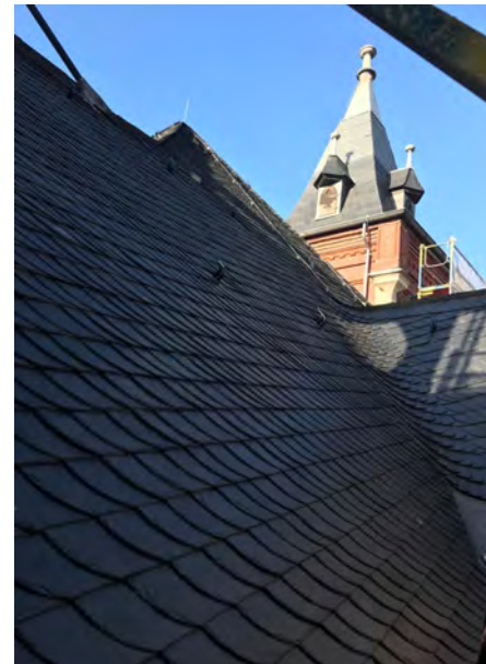
Das neue Schieferdach in Altdeutscher Deckung. (Foto: Claudia Borris)
